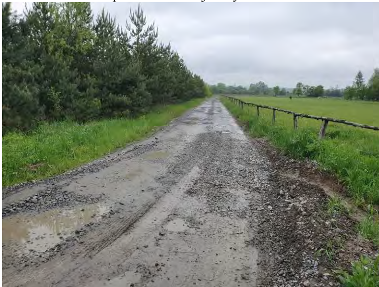
Foto 4: Pohled na plochu Z01 od jihovýchodu.
